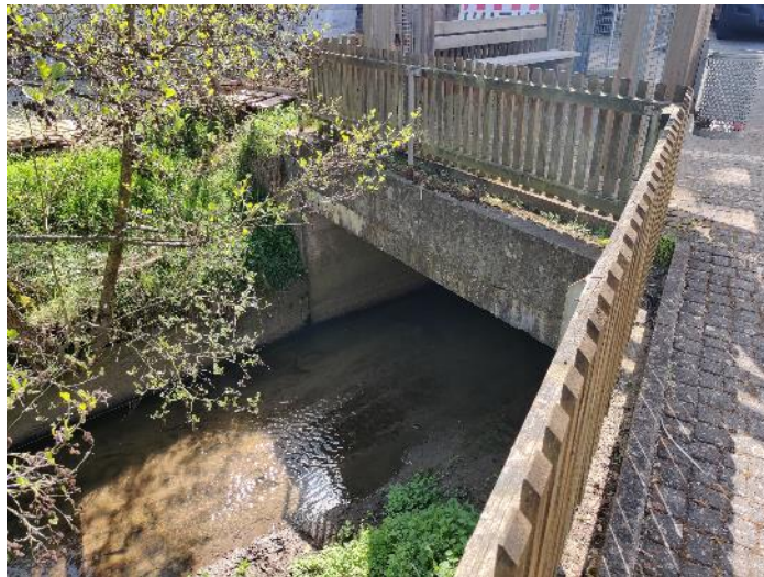
Ende der Verrohrung der Wiera
