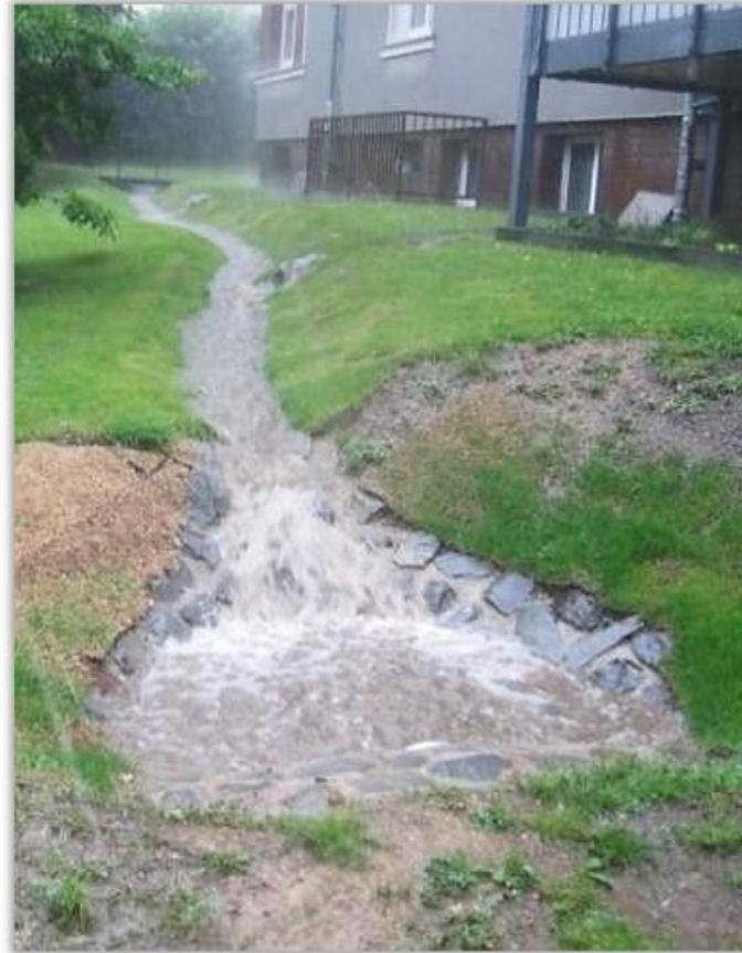
Versickerungsmulde bei Starkregen in Solingen © Kopperschmidt
