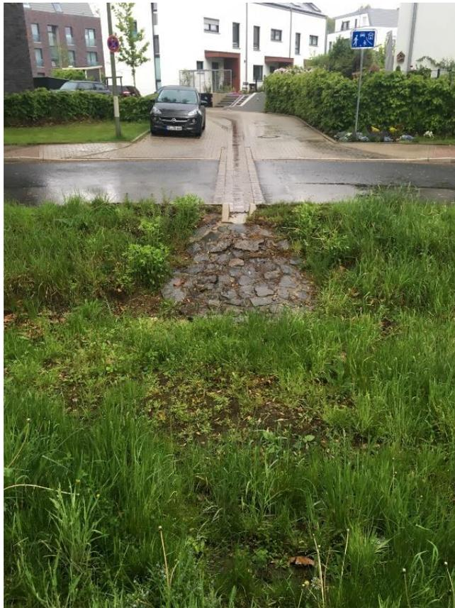
Regenwasser wird gesammelt oberflächlich in eine zentrale Versickerungsfläche geführt.
