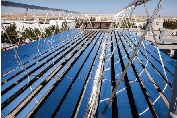
Fresnel Kollektor Quelle: Industrial Solar
