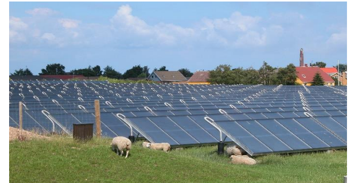
Flachkollektoren Quelle: Projekt Nahwärmeversorgung Marstal
